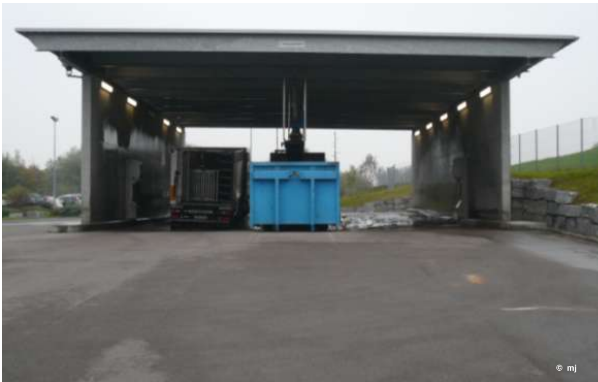
Waschanlage beim Schlachthof.
